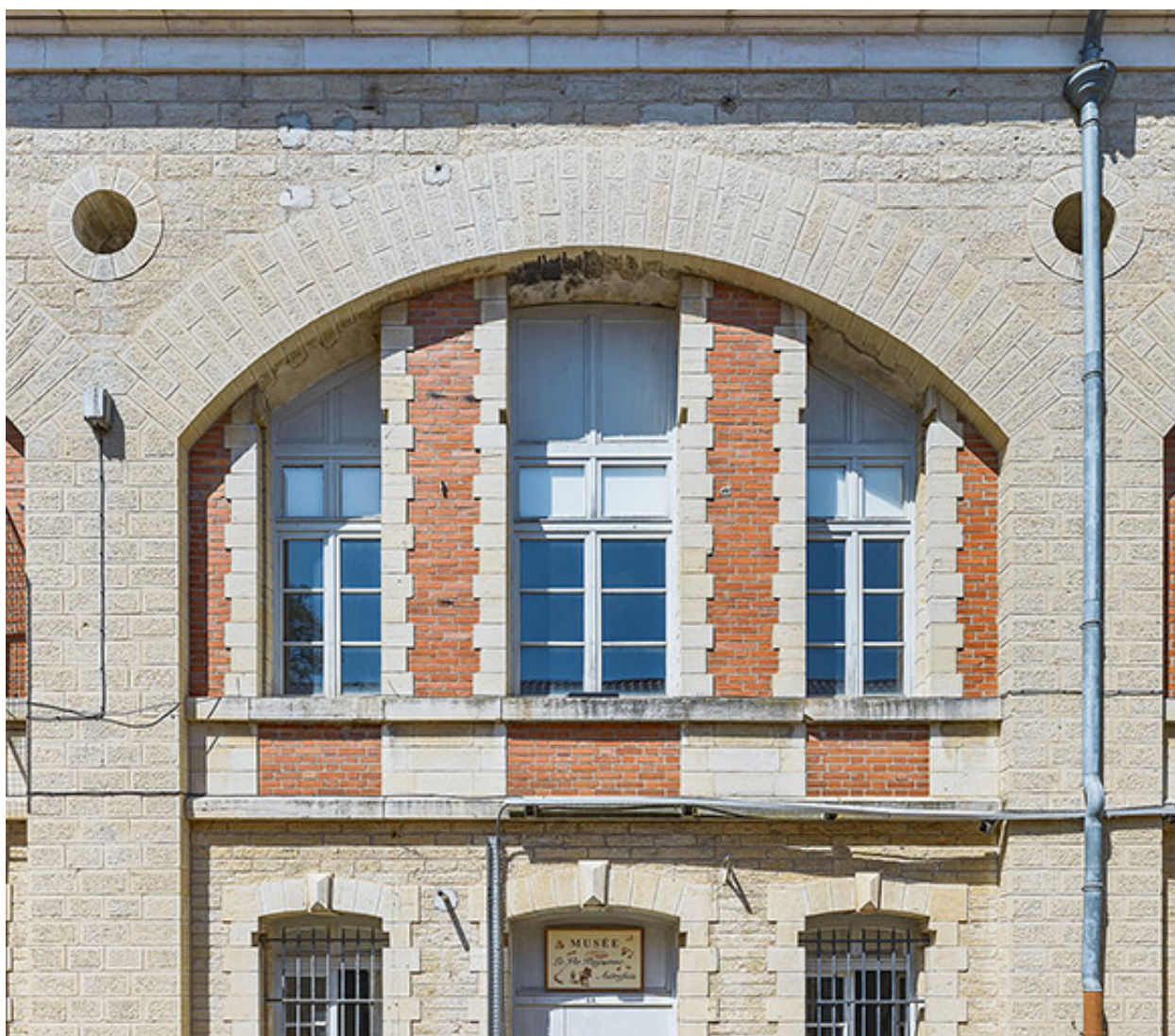
Façade d'une travée de la caserne en arc segmentaire.
