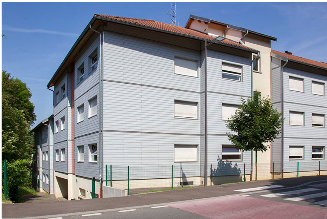
Pignon sud de l'internat, angle sud-est.
