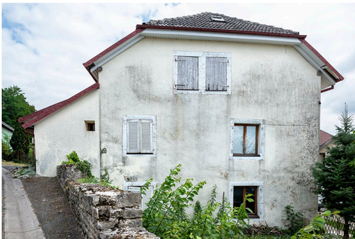
Bâtiment de 1723 : façade latérale gauche.
