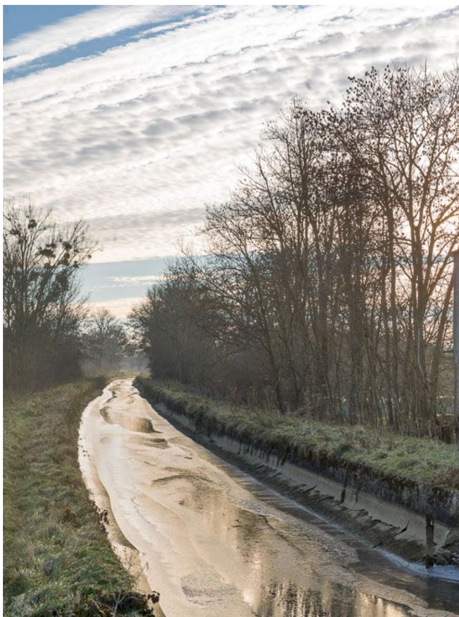
La rigole d'alimentation rive gauche.
