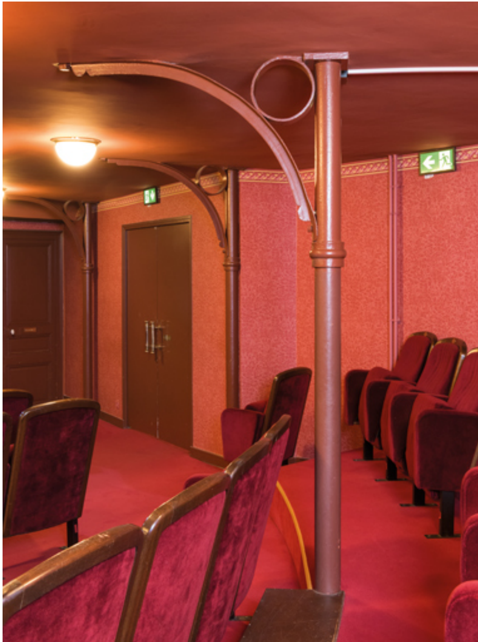
Poteaux métalliques supportant le 1er balcon.
