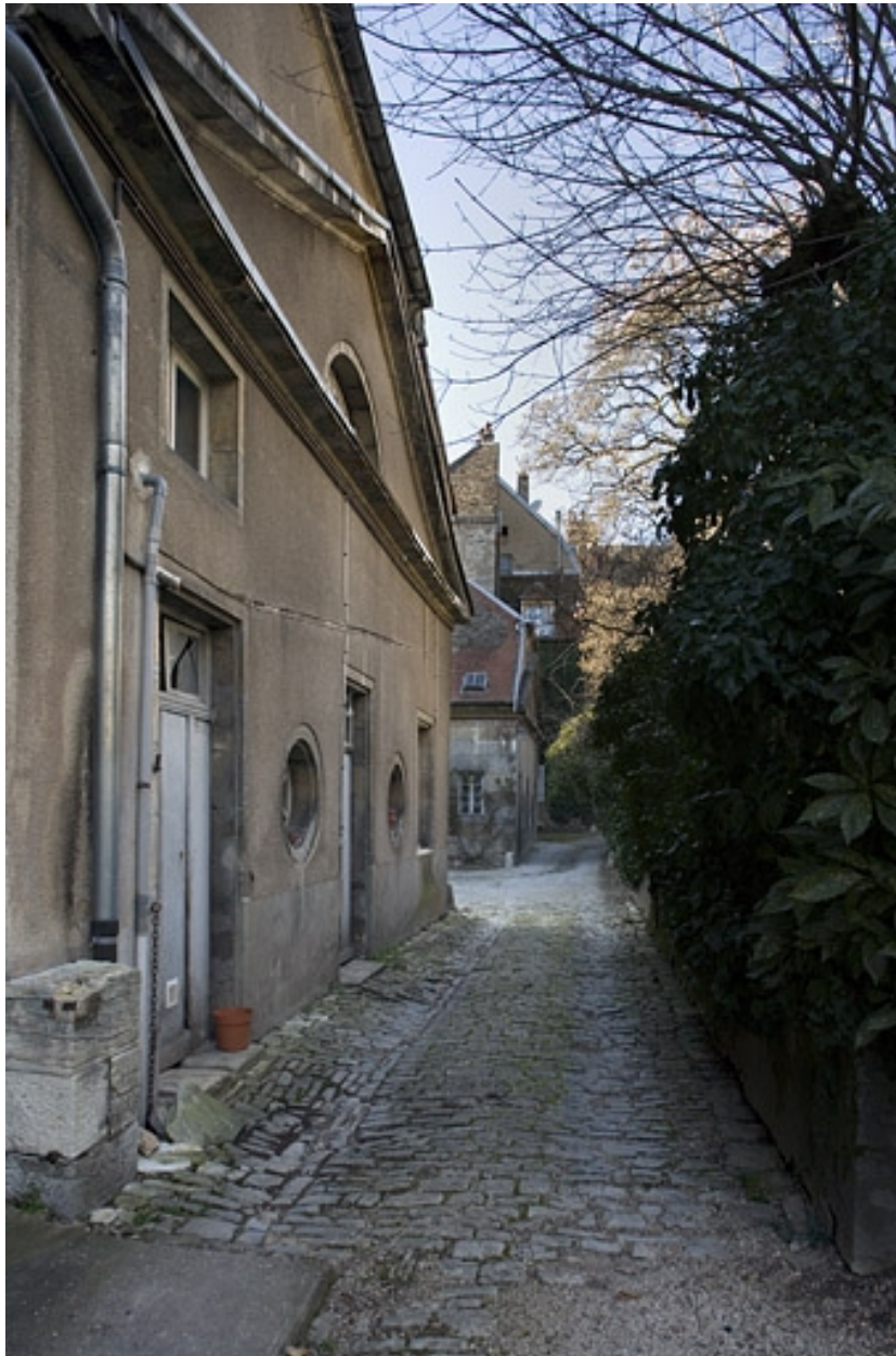
Vue d'ensemble de profil du bâtiment des remise et écurie gauche.
