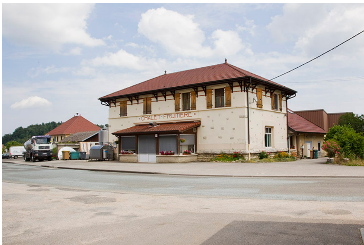
Façades antérieure et latérale droite.
