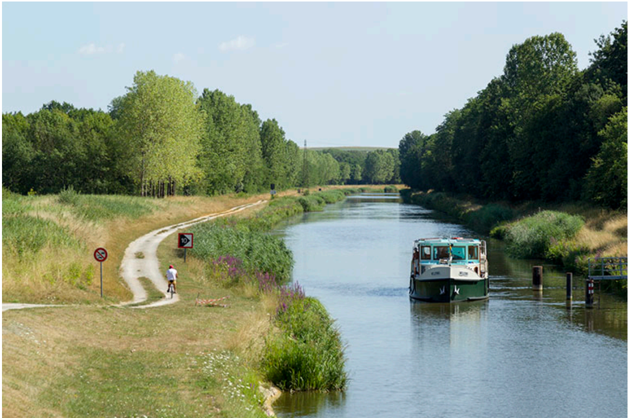
La dérivation au niveau de Ray-sur-Saône avec le chemin de halage.
