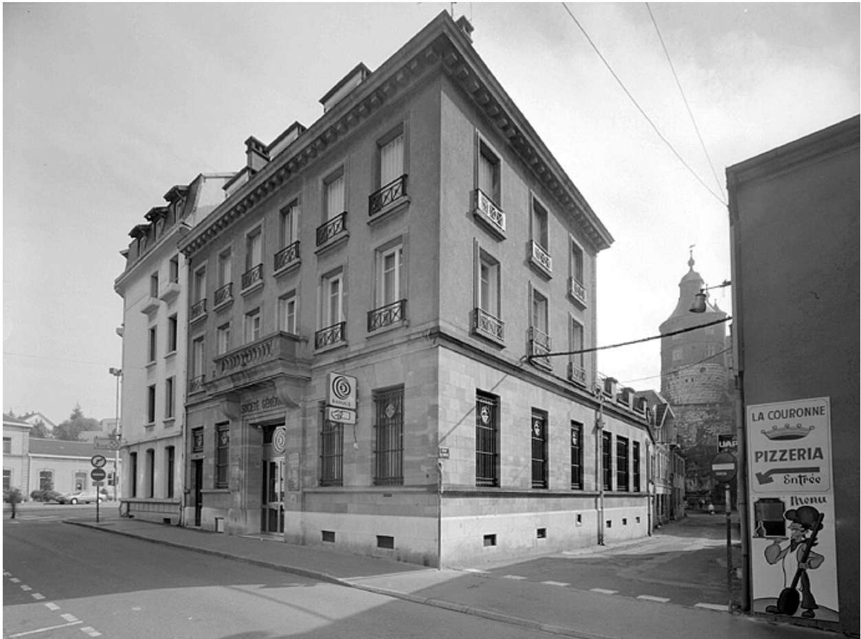
Vue d'ensemble à l'angle des rues Cuvier, à gauche, et de la Mouche, à droite.
