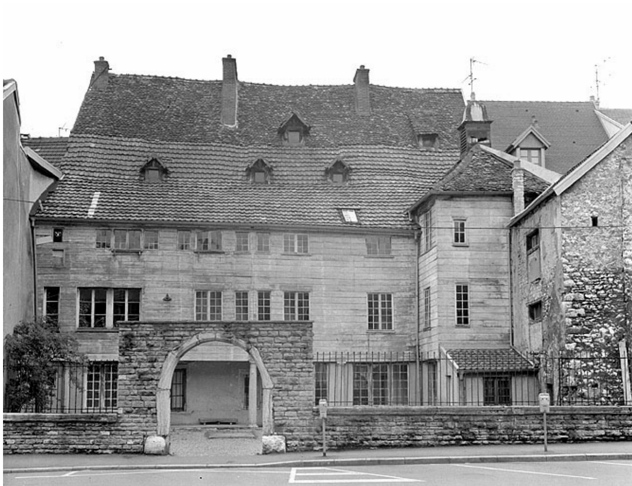
Façade sur cour.
