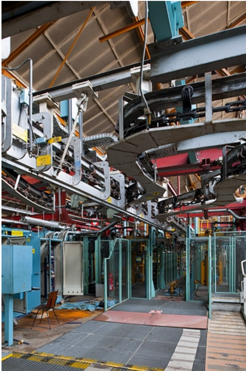
Atelier de montage désaffecté (5).
