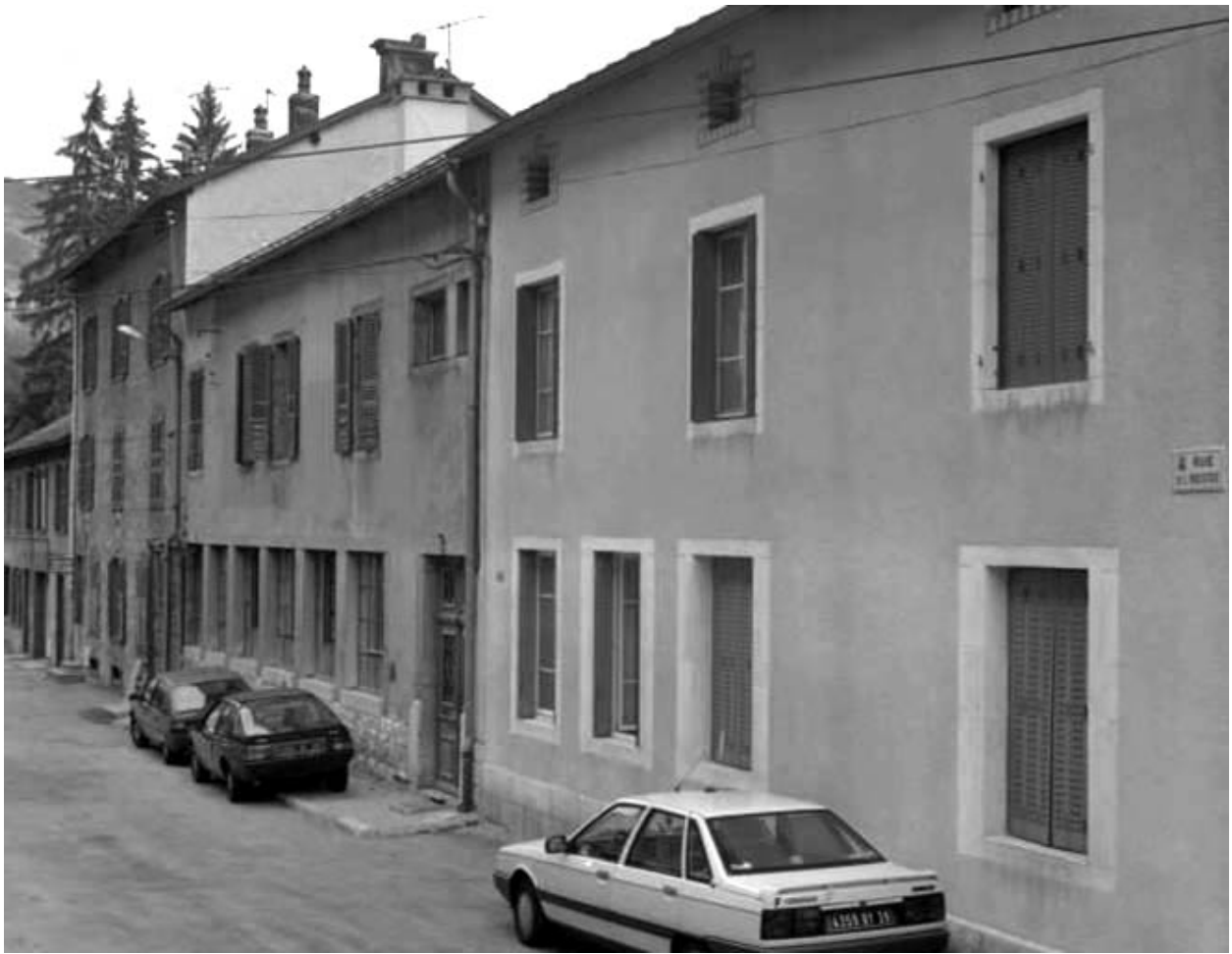
Façades sur la rue de l'Industrie.
