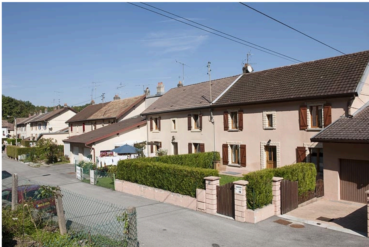
Vue d'ensemble rue de la Promenade.
