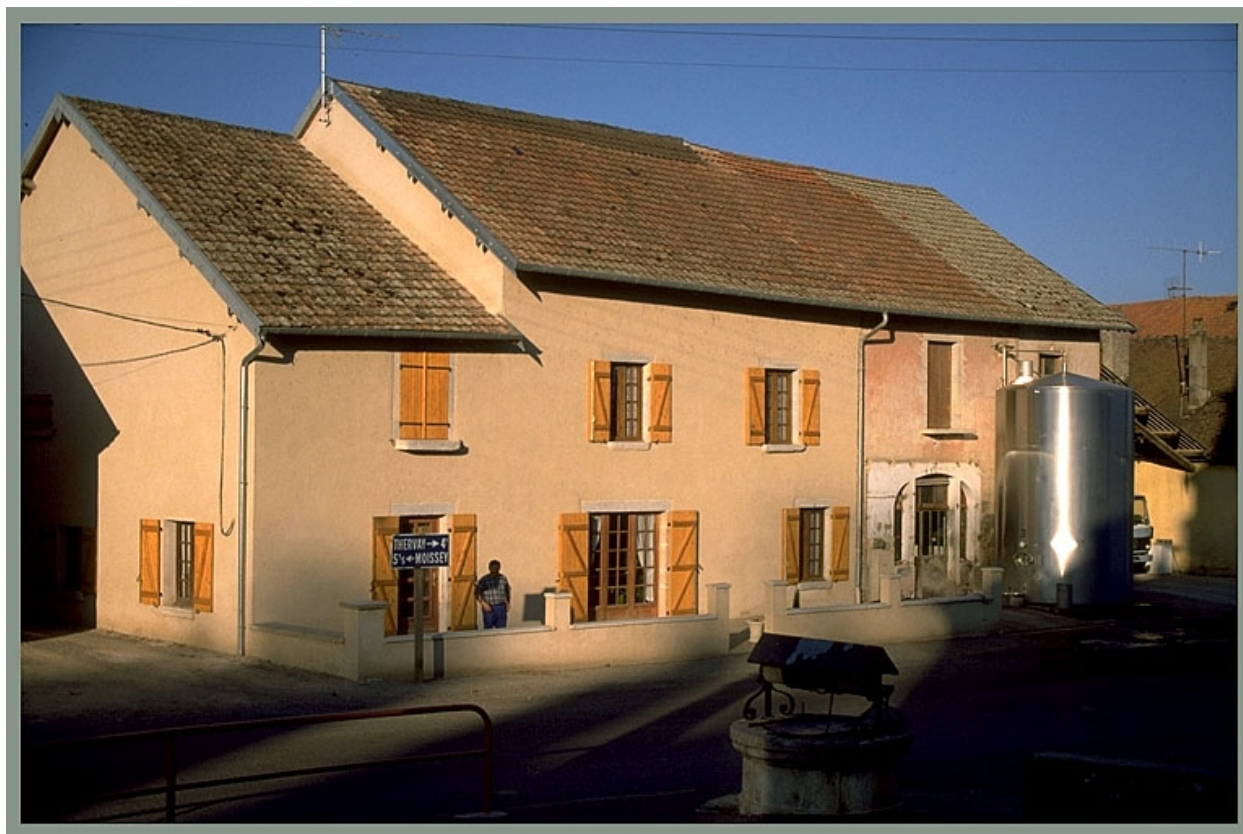
Façade antérieure vue de trois quarts gauche.
