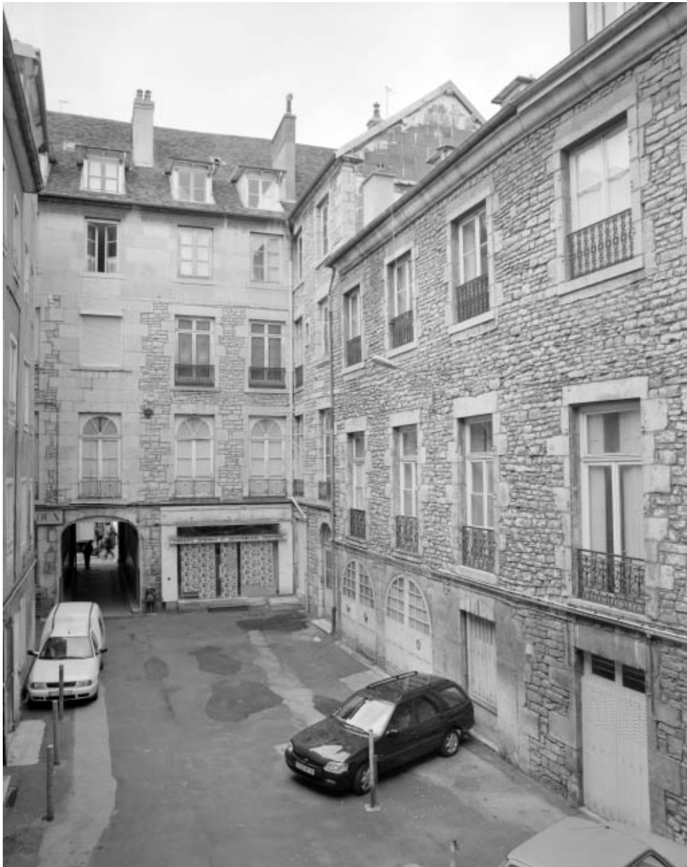
Vue de la première cour, depuis le logis sur cour : détail de l'aile des remises.
