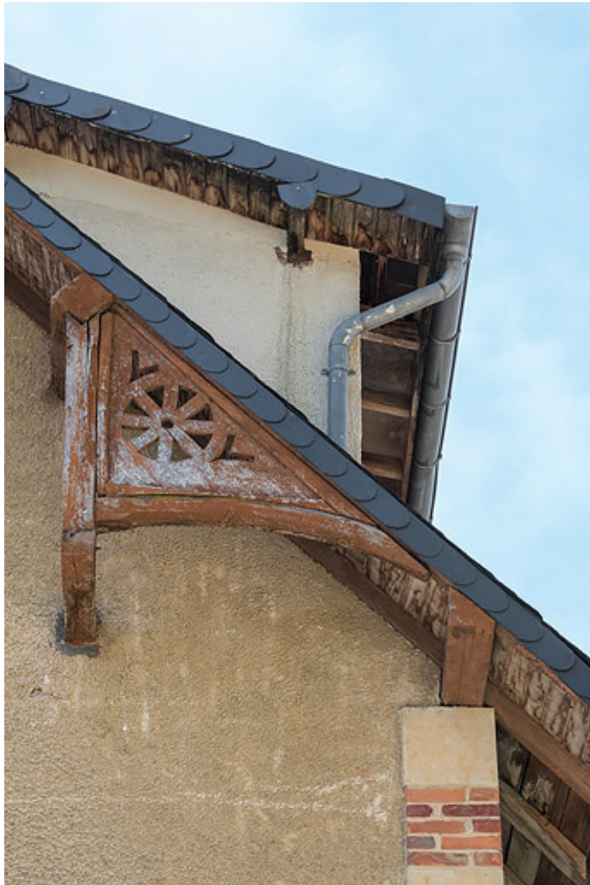
Pignon nord-est, éléments de charpente apparente (sous-arbalétriers, cercles).
