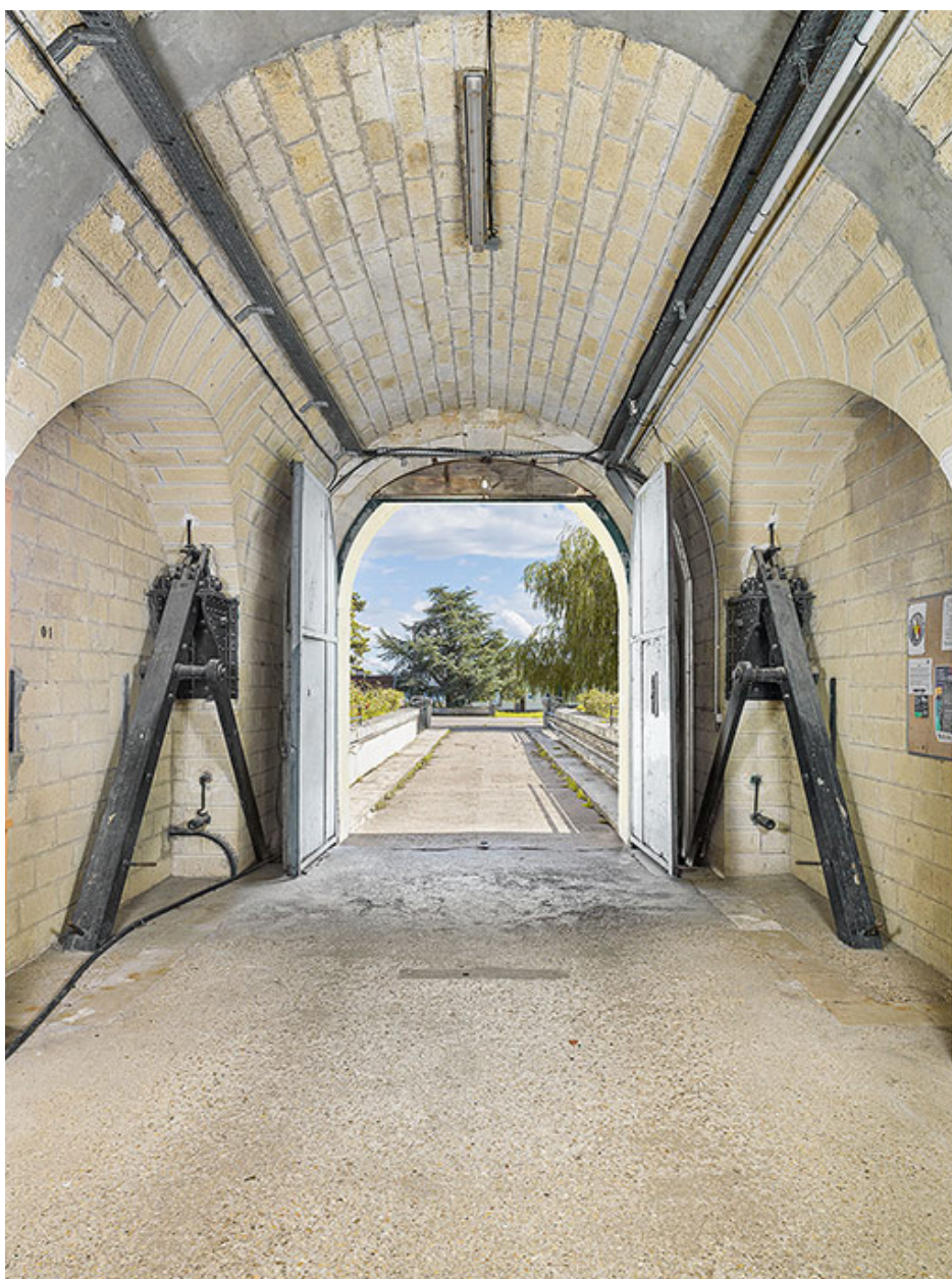
Sas d'entrée du fort.
