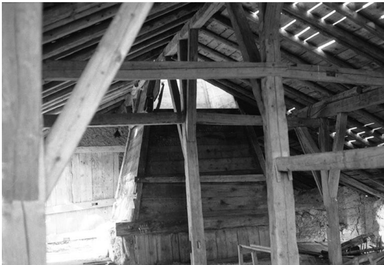
Charpente et "tué".
