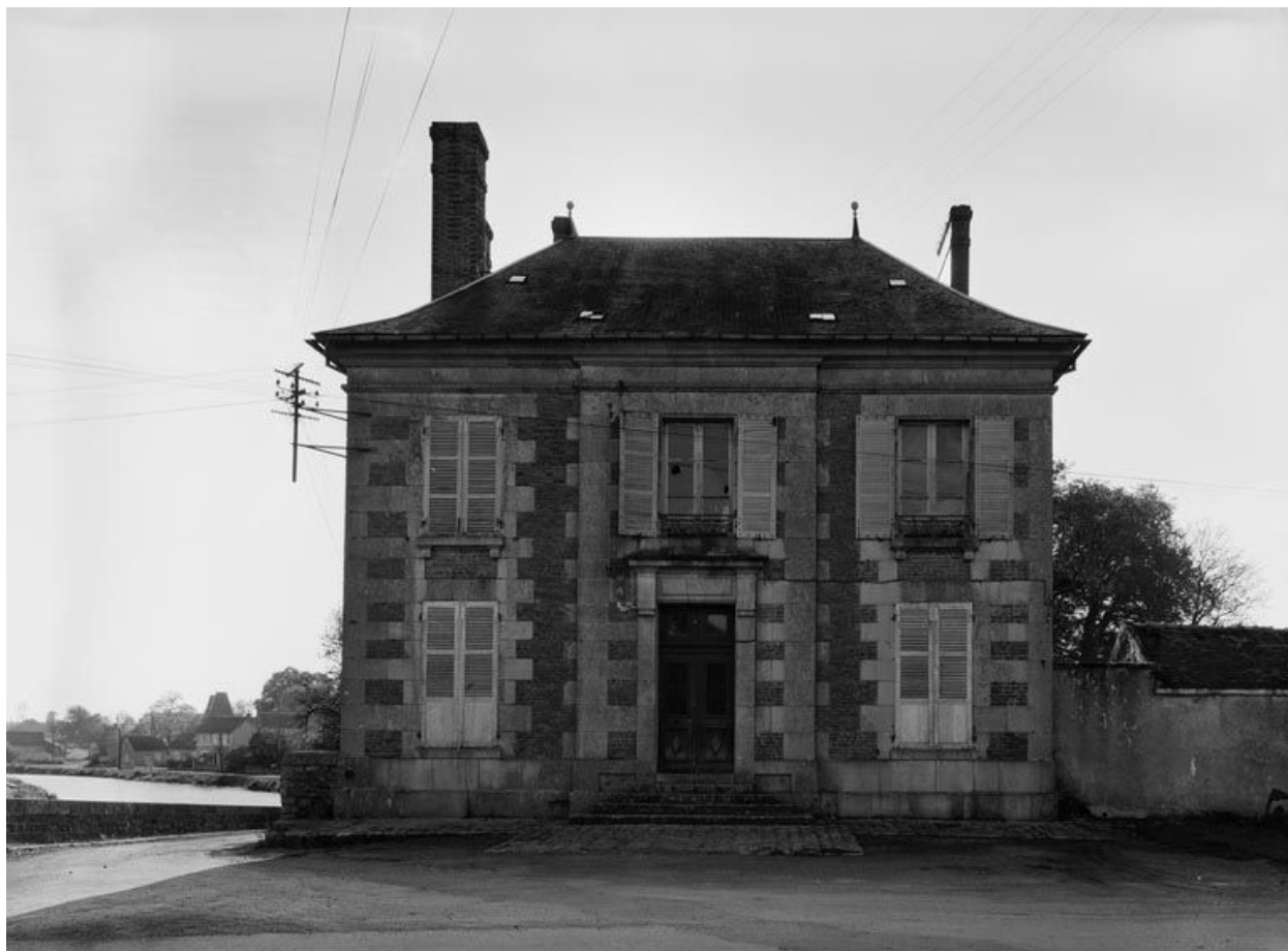
Vue de la façade principale (en 1975).
