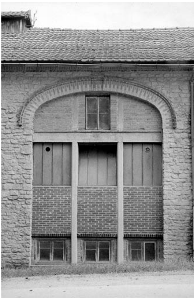
Atelier (A) : détail d'une travée large.
