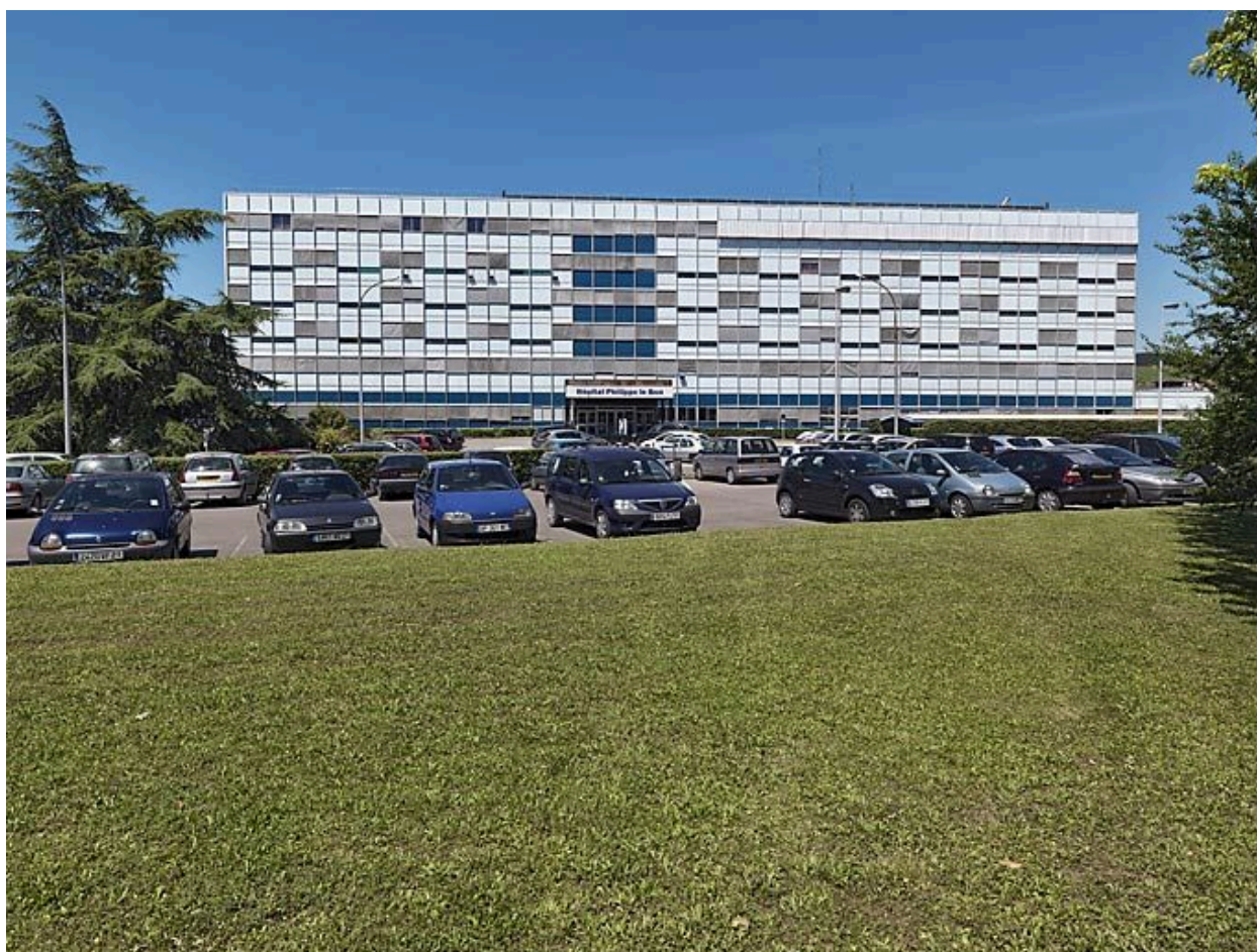
Bâtiment principal, façade.
