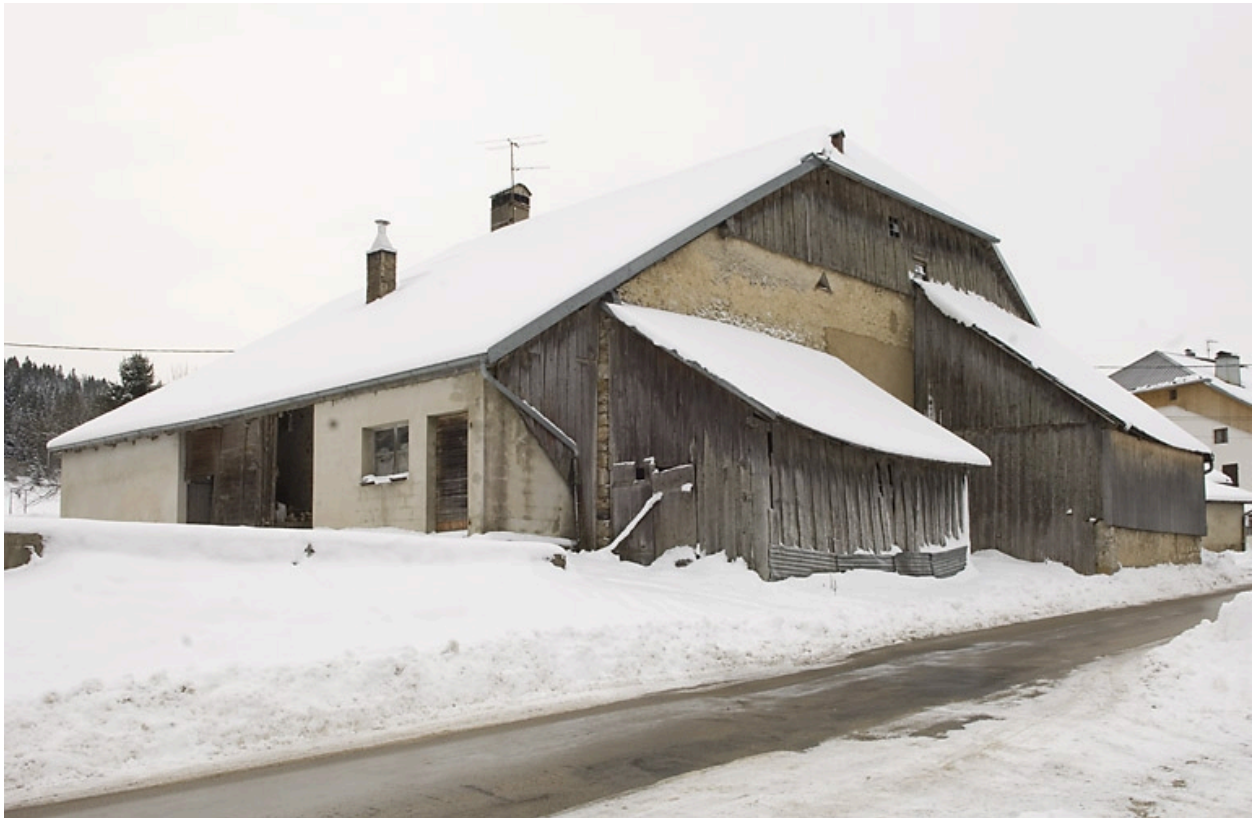
Façades postérieure et latérale gauche.
