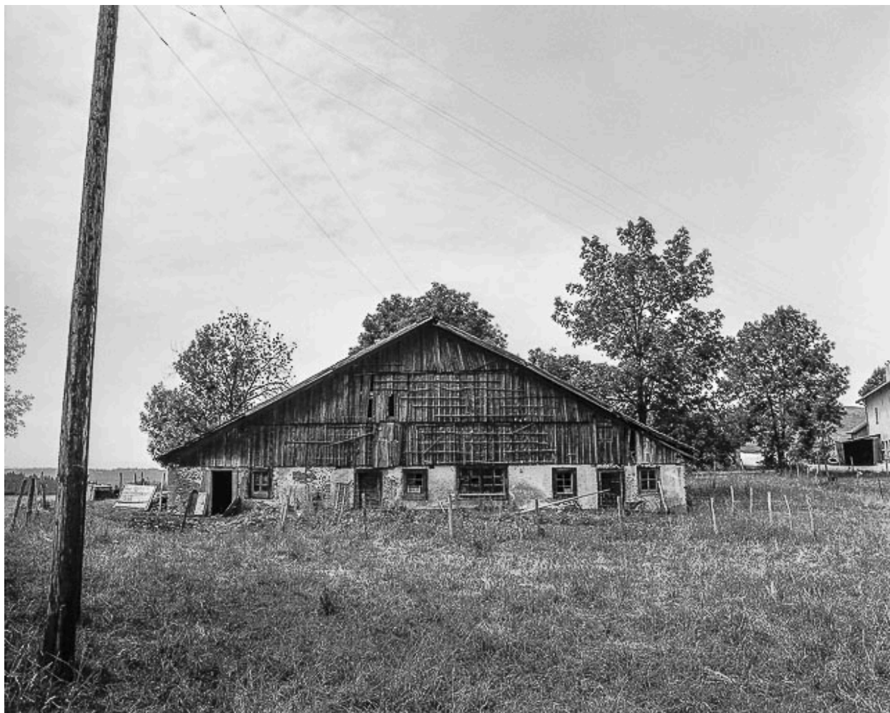
Ferme située au lieudit Mancerneux, cadastrée 1966 C2 138 : vue d'ensemble.
