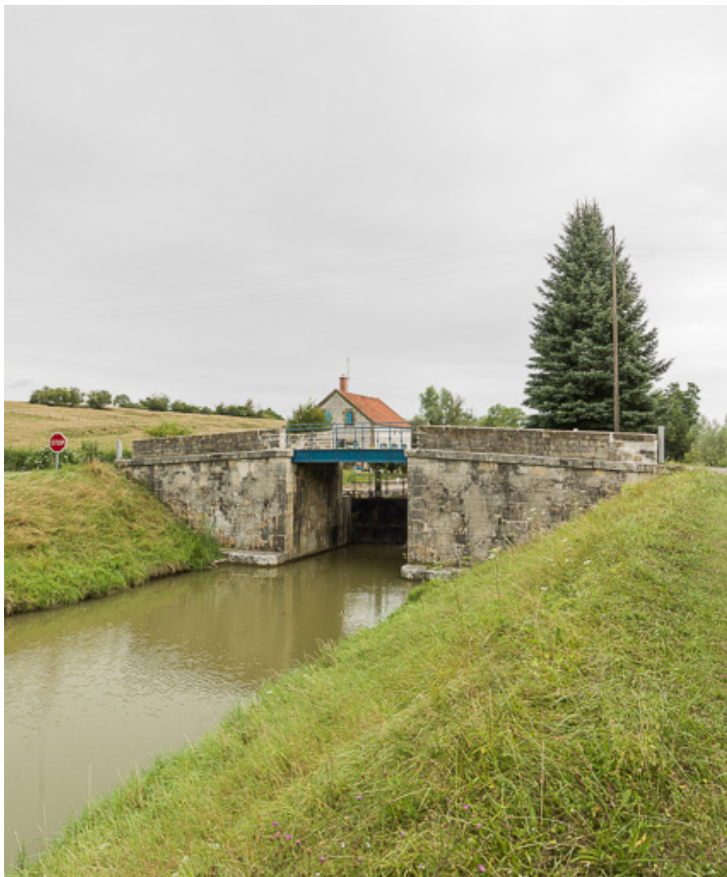
Vue d'ensemble du pont.
