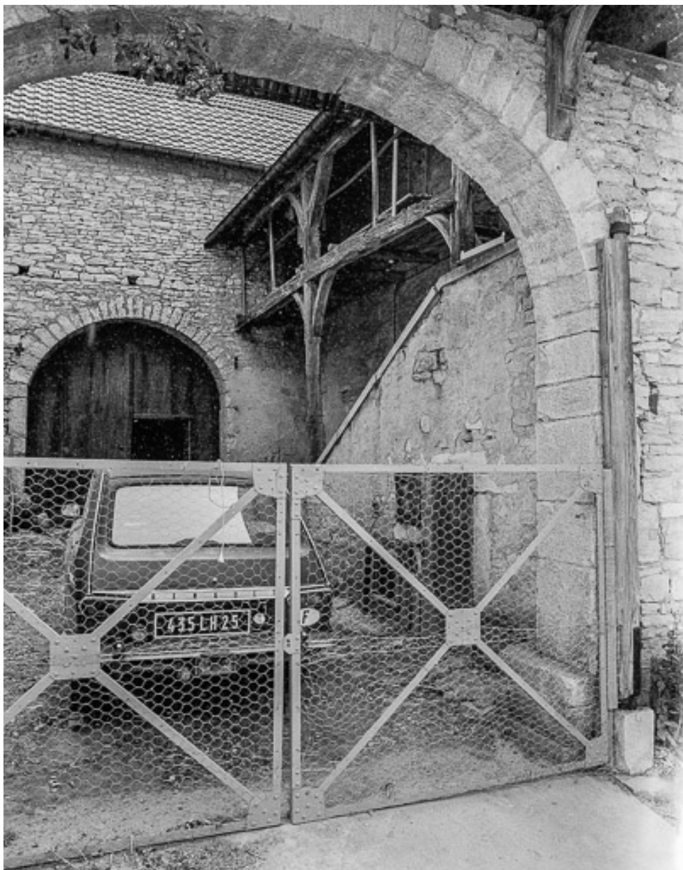
Cour intérieure, côté droit : escalier.
