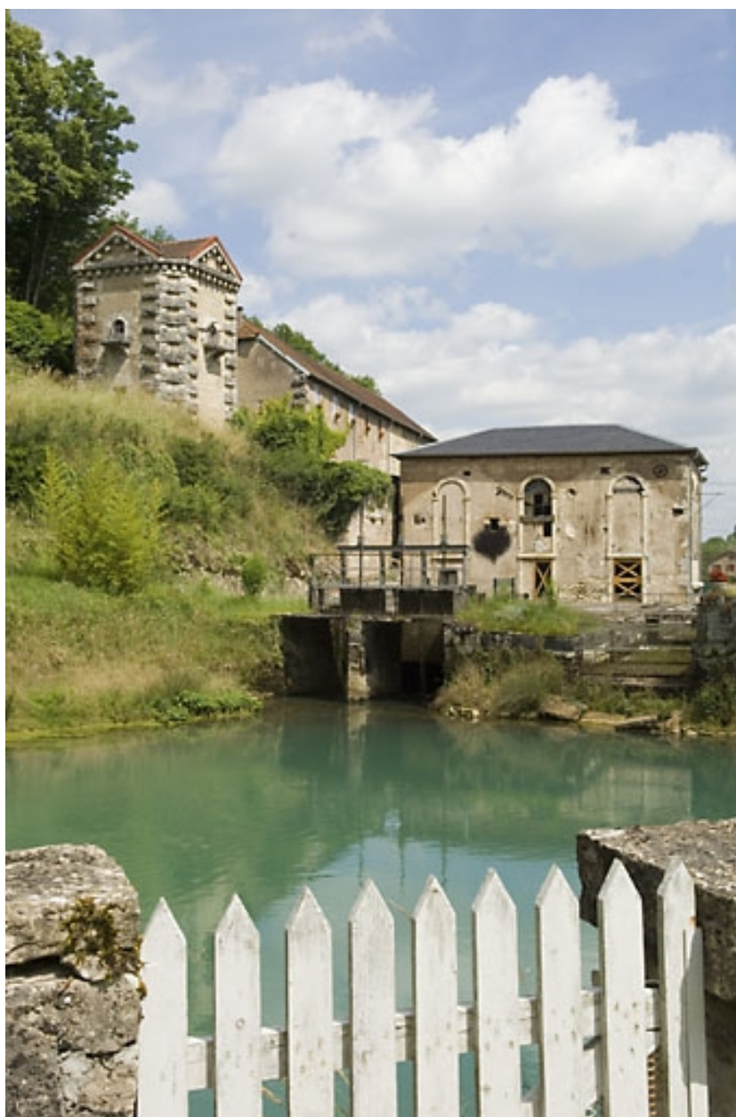
Pigeonnier, halle à charbon et salle des machines depuis la source de la Baignotte.
