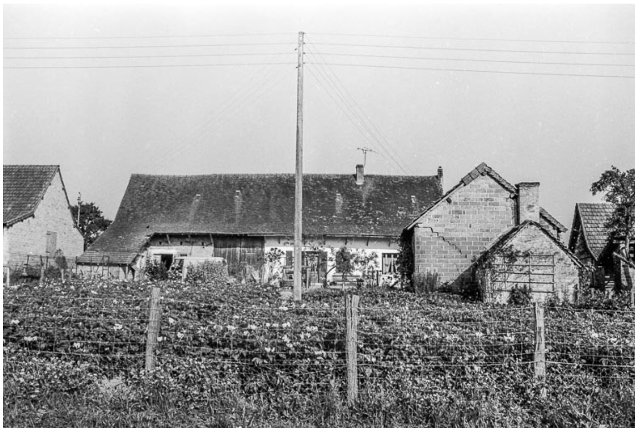
Ferme cadastrée 1956 A1 169 : façade antérieure.
