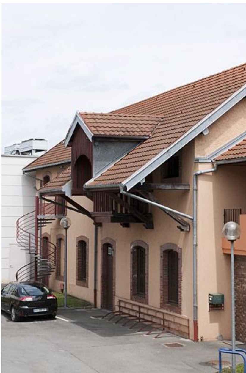
Façade des magasins de stockage.
