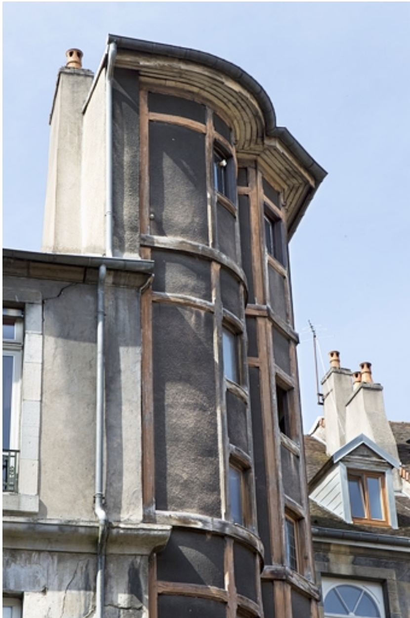
Détail de la partie supérieure de la cage d'escalier en pan de bois.
