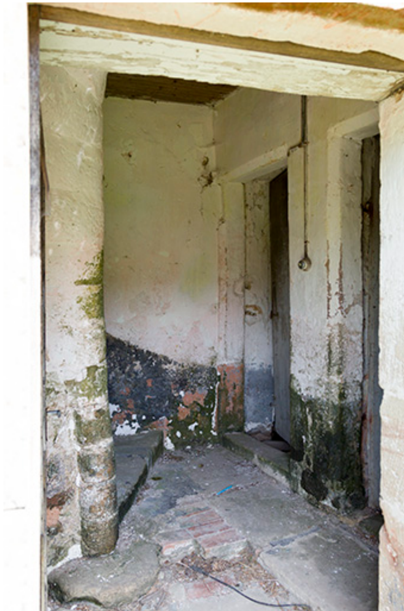
Bas de l'escalier à vis, maison Thysac.
