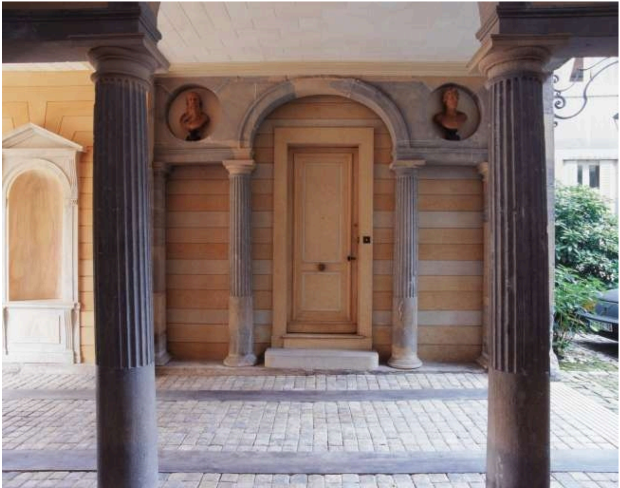
Passage d'entrée : détail de la partie gauche depuis le vestibule droit, de face.
