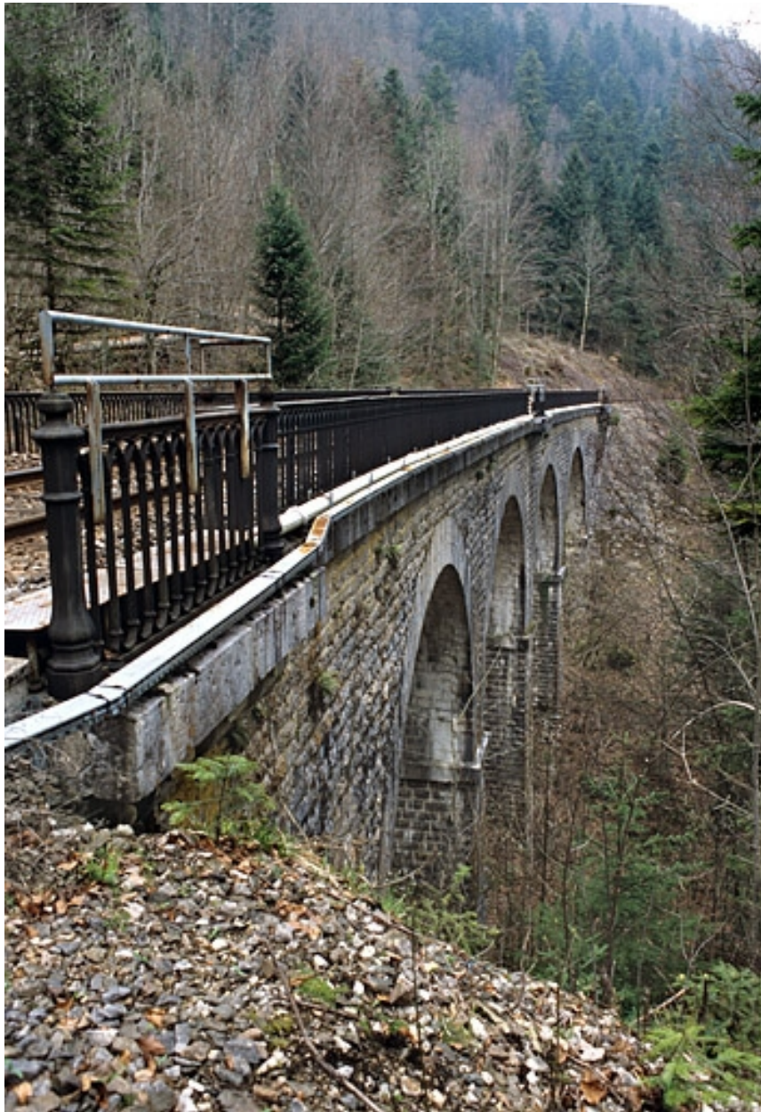
Viaduc : élévation nord (côté vallée), vue en enfilade.
