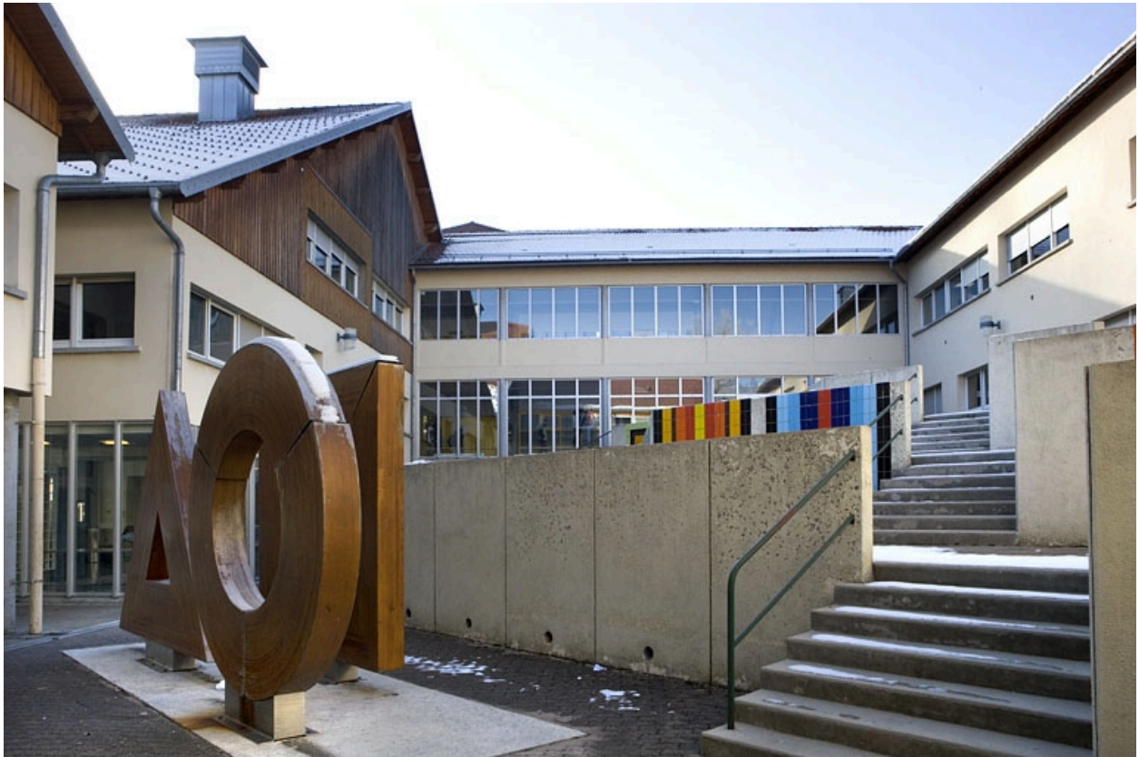
Site récent : cour intérieure avec l'oeuvre de Comby, en avant de l'entrée des élèves.
