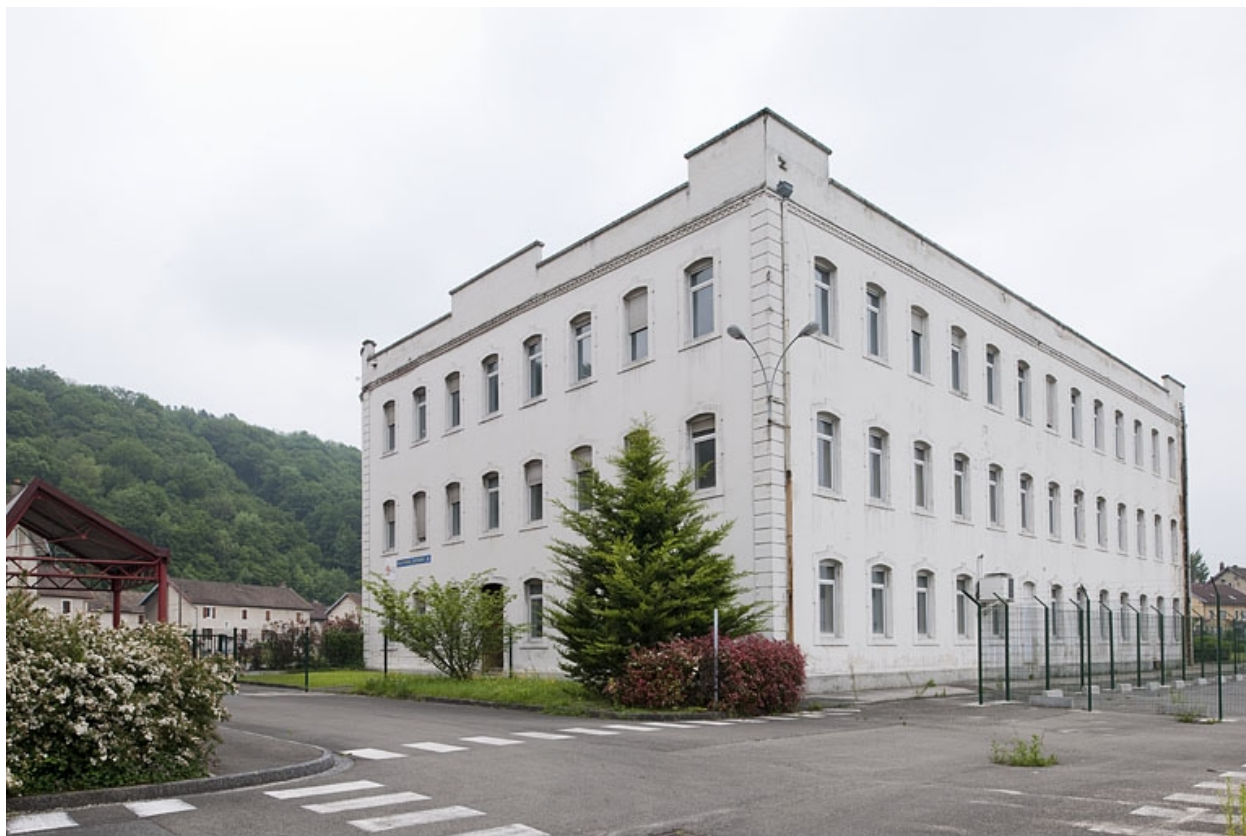
Immeuble de bureaux. Vue depuis le sud-ouest.
