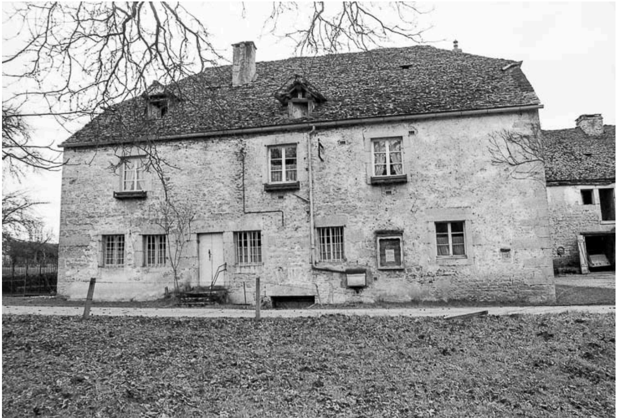
Logement d'ouvriers, puis école (1979).
