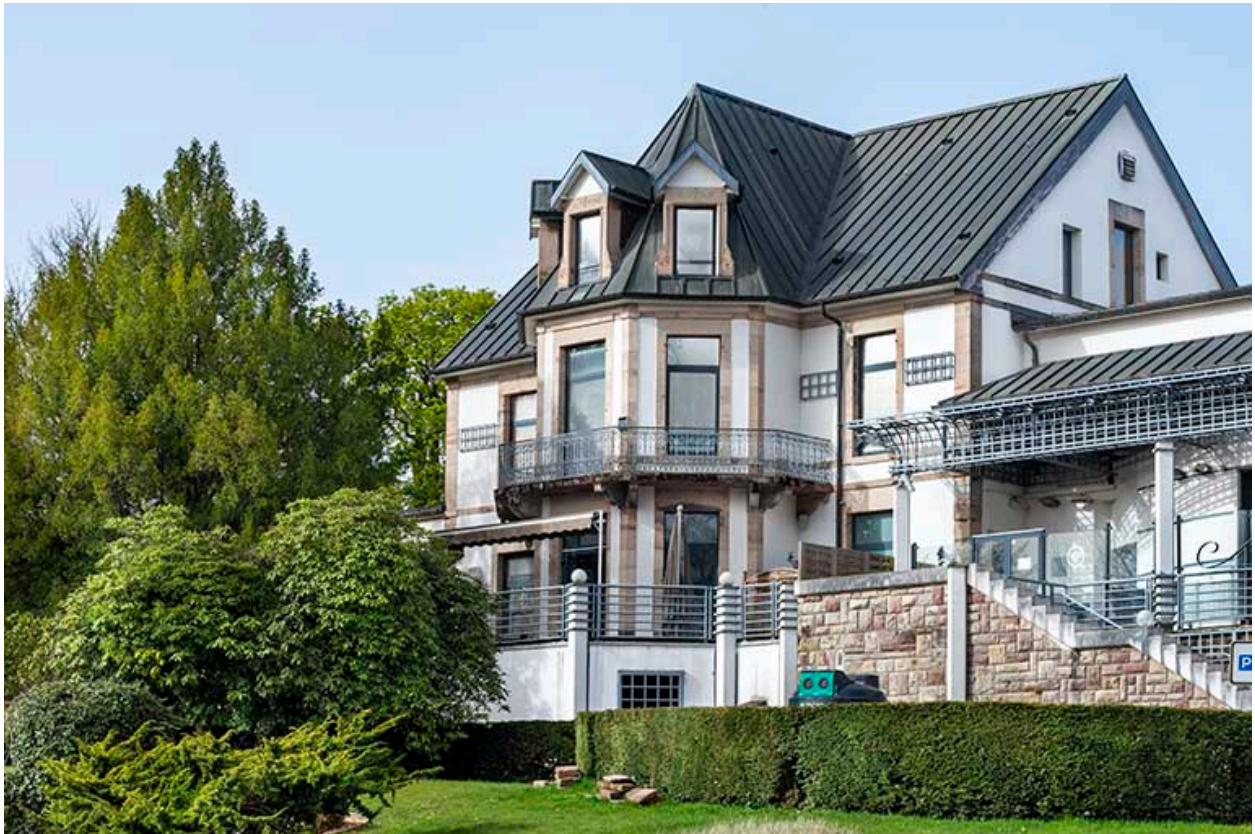
Maison, vue depuis le nord.
