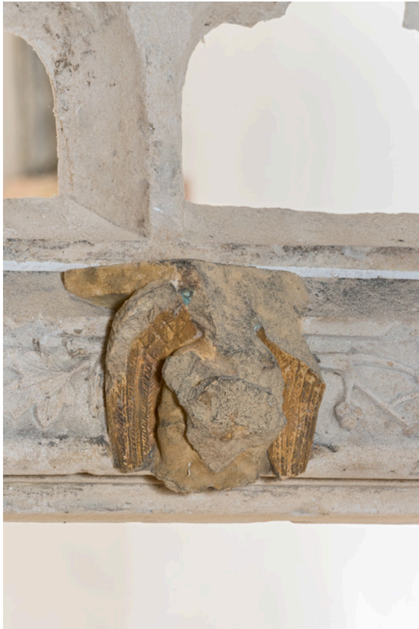
Détail : ange porteur d'écu du linteau.
