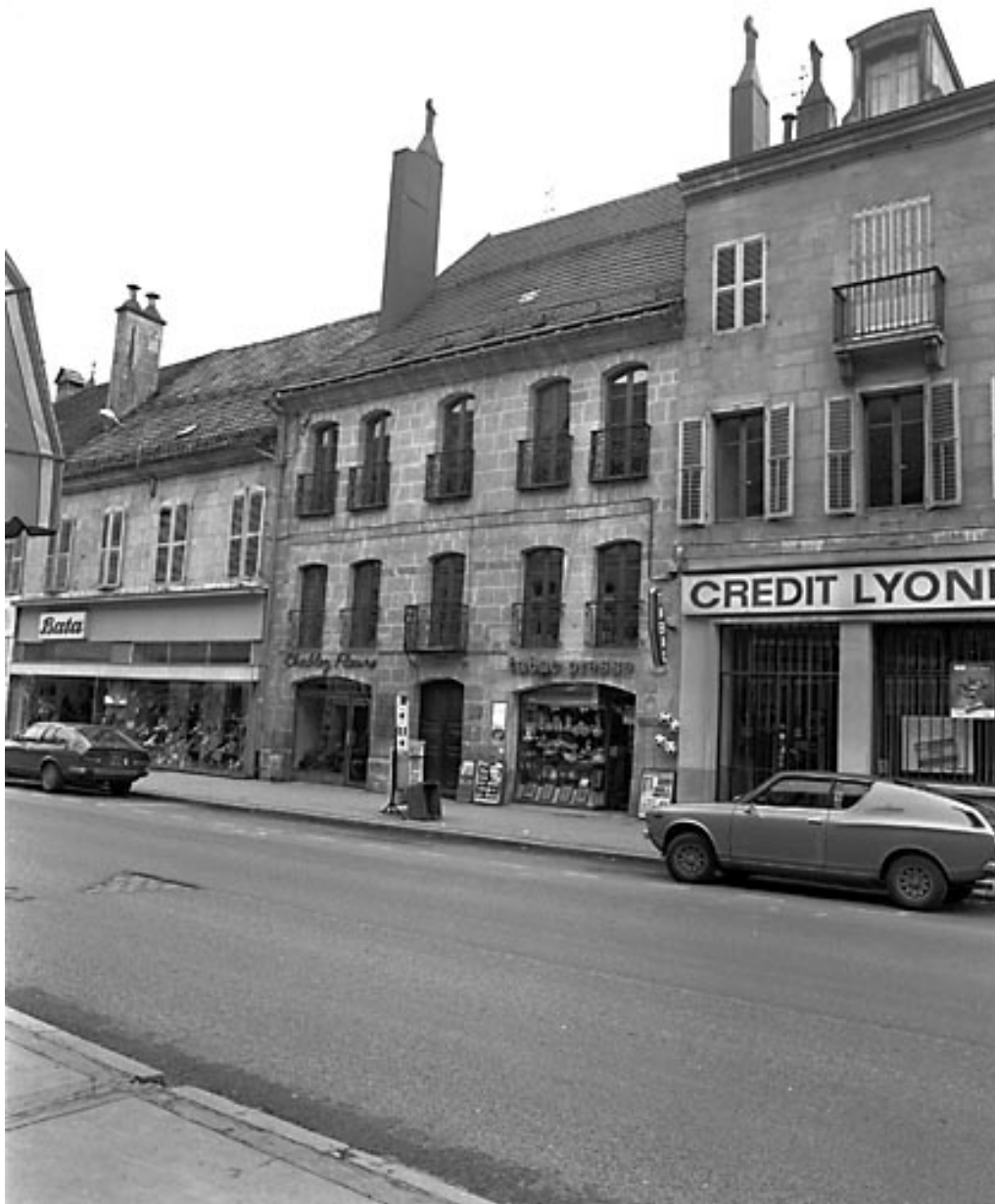
Façade sur rue de trois quarts.
