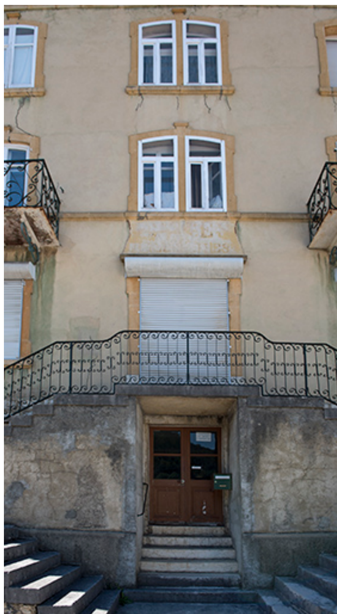
Façade antérieure : travée centrale et escalier.
