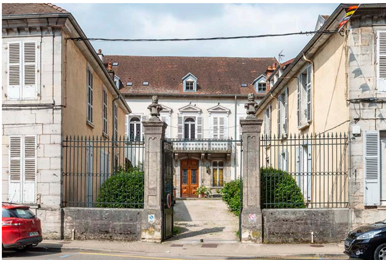
Vue de la cour depuis l'est.
