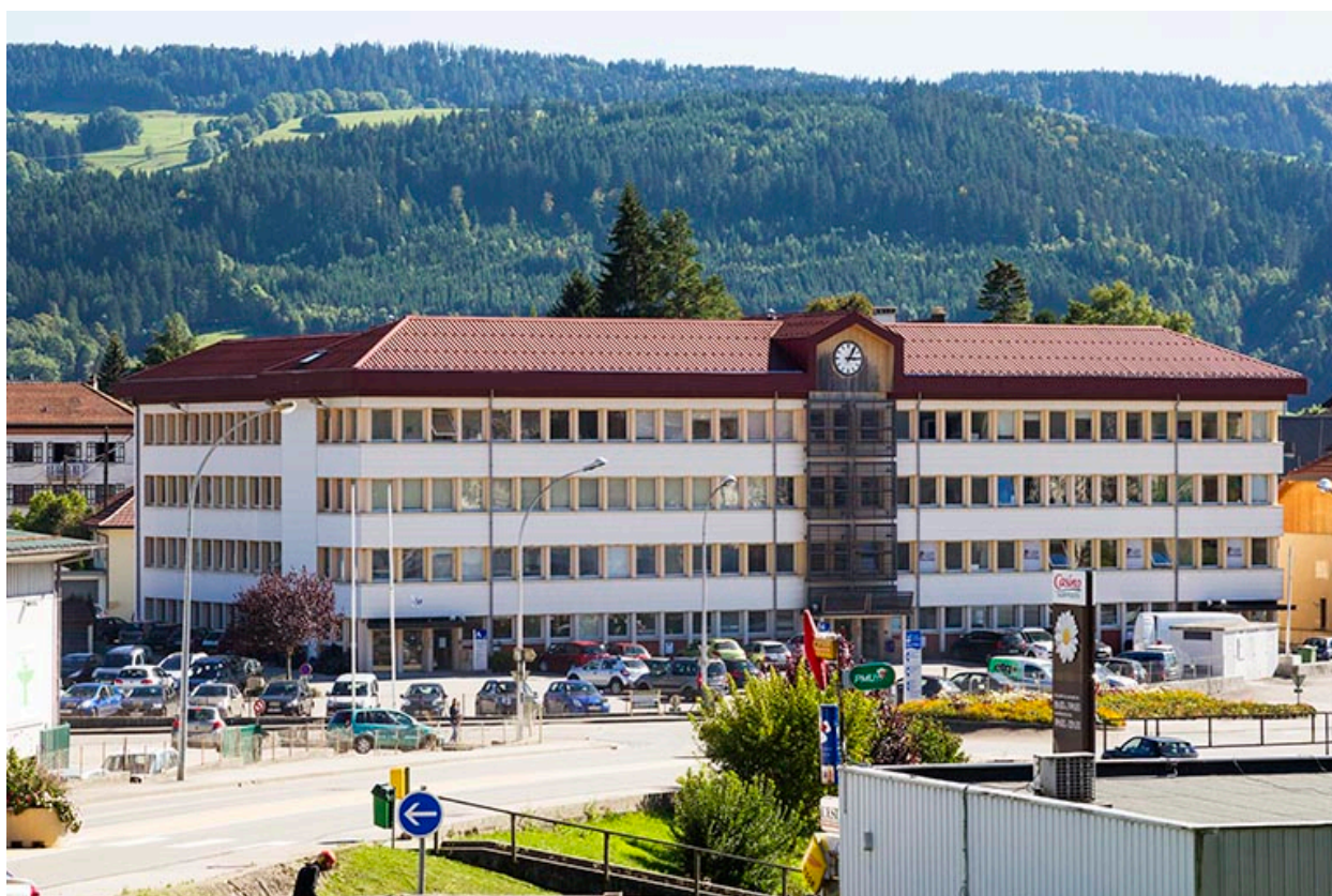
Usine : façades antérieure et latérale gauche.
