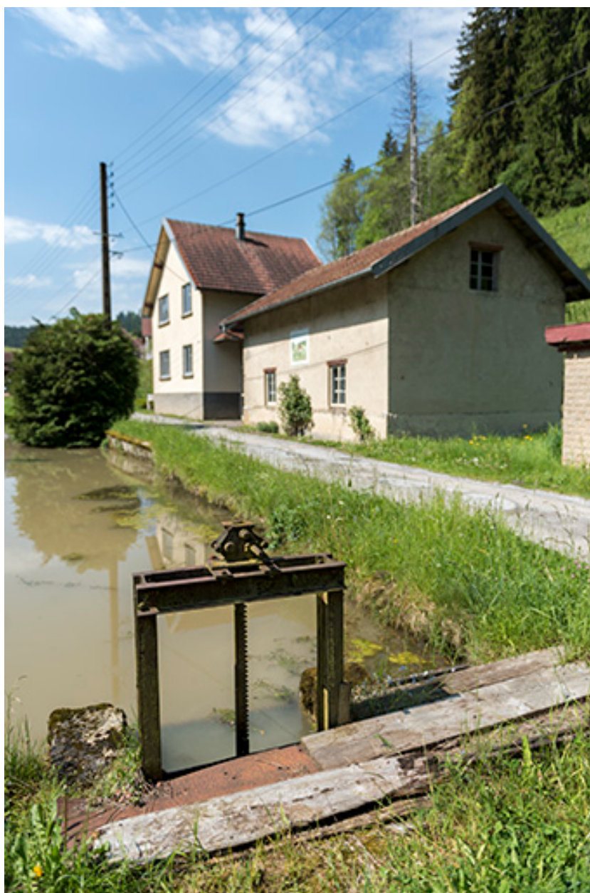
Vanne de prise d'eau, remise et maison.
