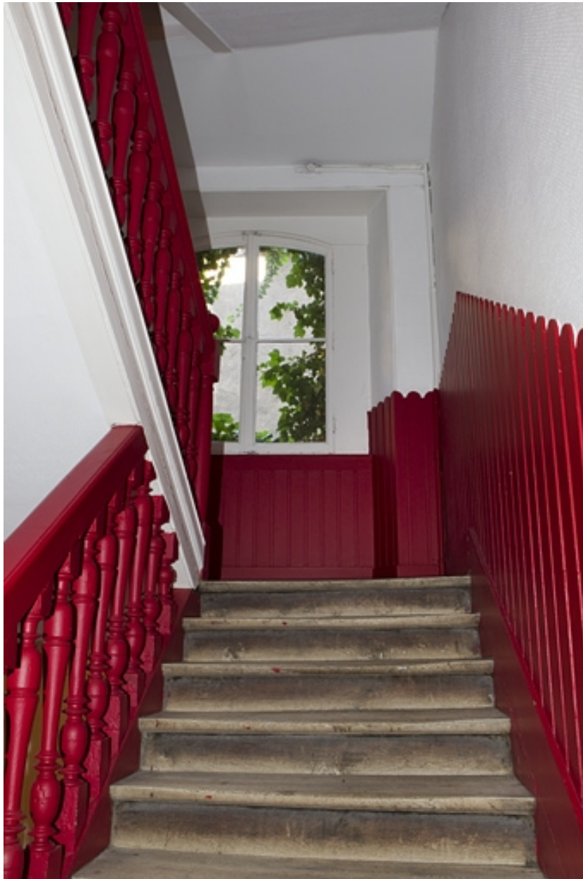
Logis principal : détail de l'escalier.
