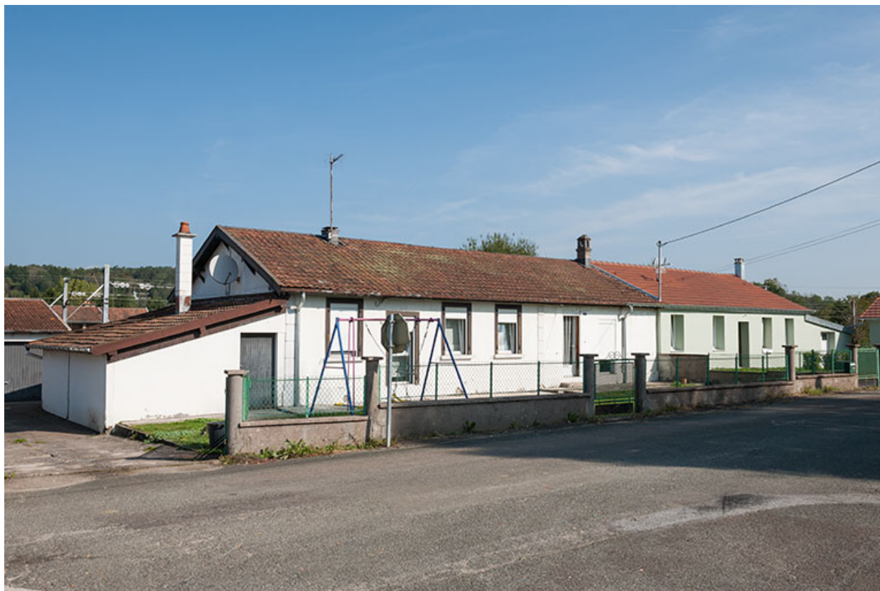
Habitation en rez-de-chaussée (3 logements).
