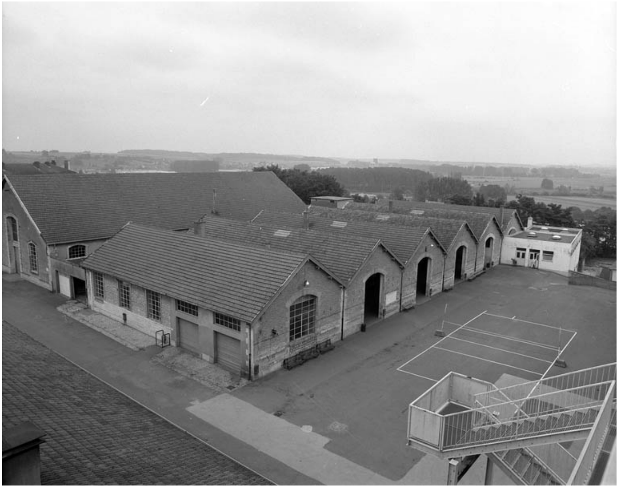
Extension de la caserne : vue plongeante sur le bâtiment droit.
