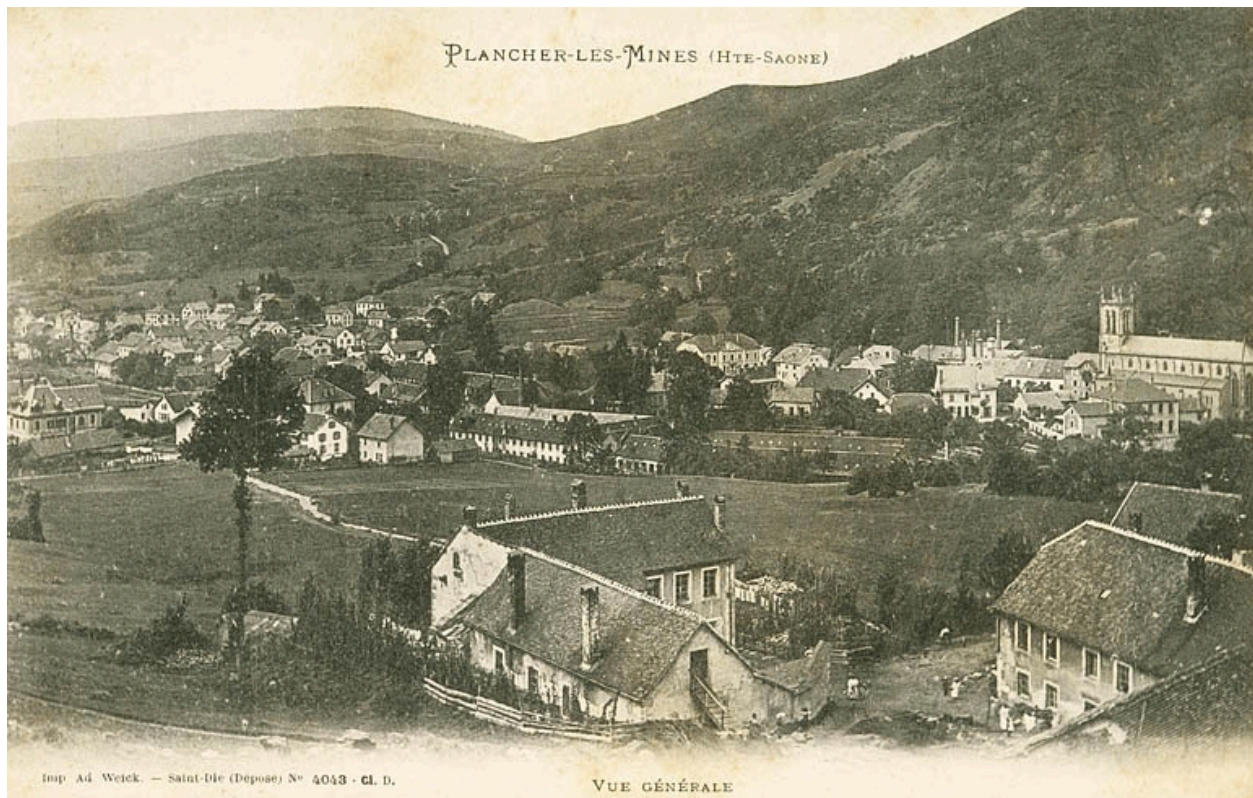
Plancher-les-Mines (Hte-Saône)- Vue générale.
