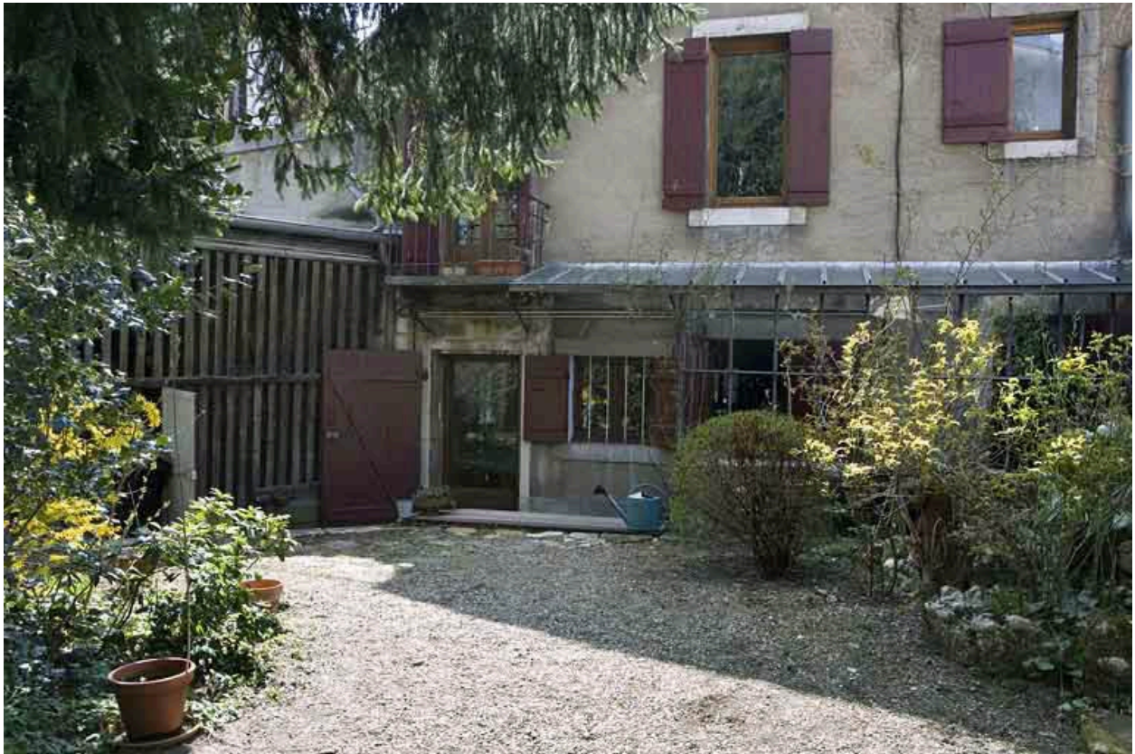
Détail du rez-de-chaussée du logis secondaire situé au fond de la parcelle.
