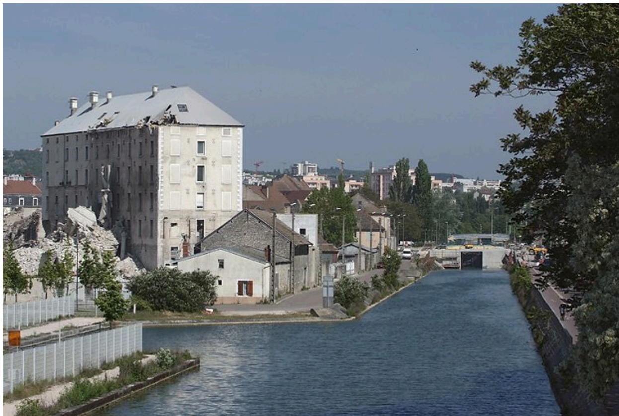
Les bâtiments en cours de démolition.
