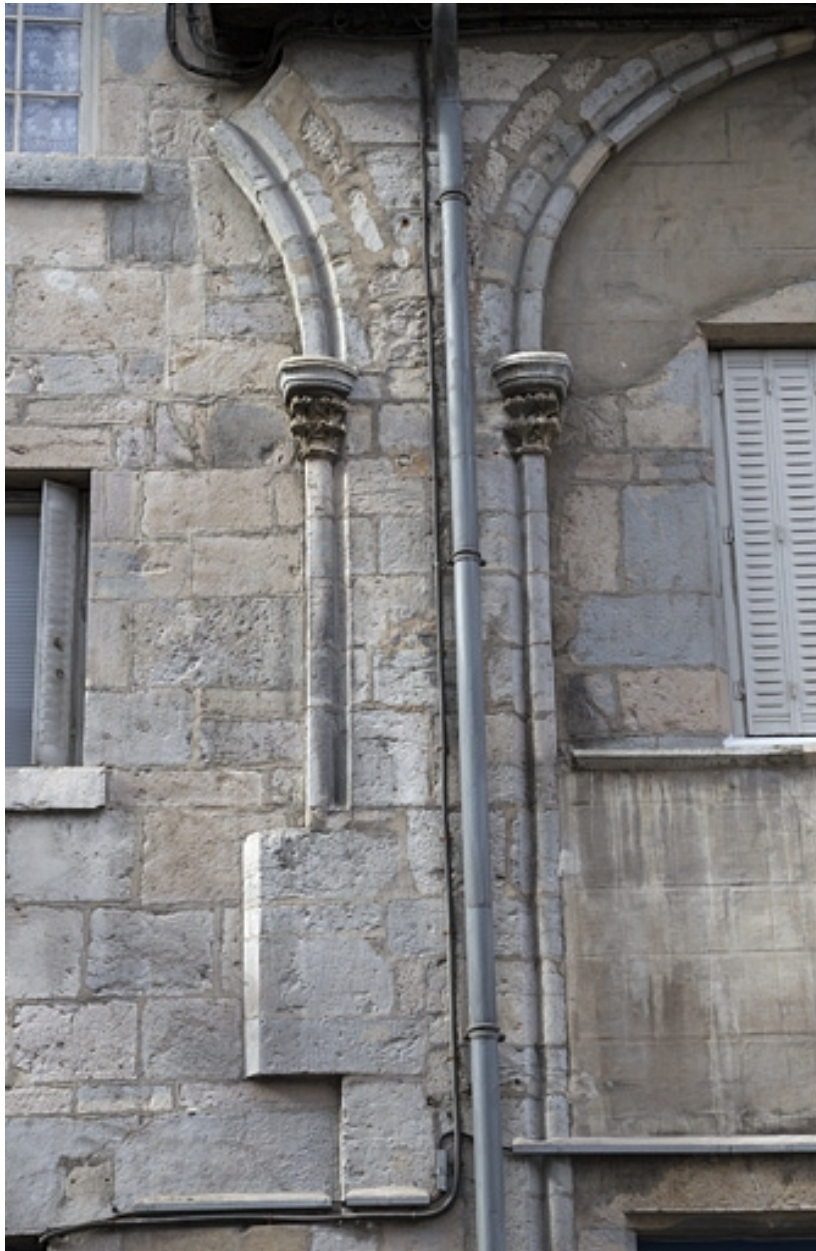
Façade antérieure : détail des arcs et des chapiteaux, vue éloignée.
