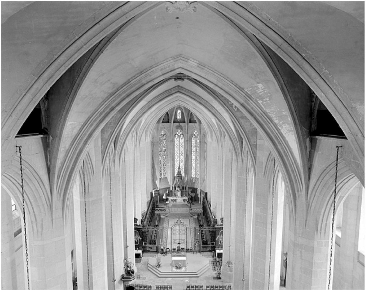
Voûtes du vaisseau central depuis la coursière haute de la façade.
